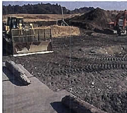
下田最終処分場
