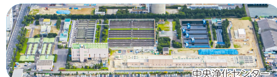
中央浄化センター
