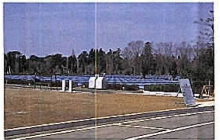
築地の造成が進められている平和公園
