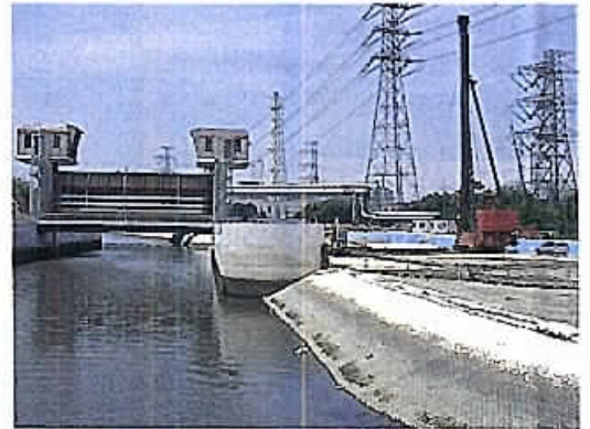
排水機場土木工事がはじまる生実川河口
