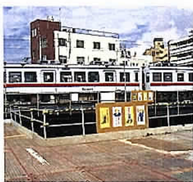
市道と京成電鉄の交差部工事(中央新千葉1丁目地)
