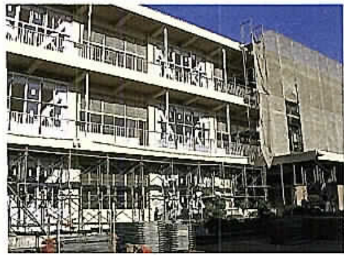
小学校の耐震補強工事
