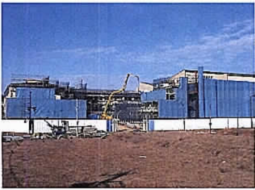
仮称総合福祉センター・ちば女性会館建設工事
