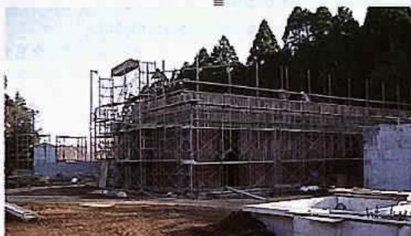
仮称更科浄水場建設工事
