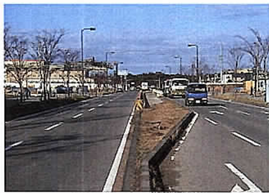
モノレールの軌道が敷設予定の市道(中央区千葉寺町)
