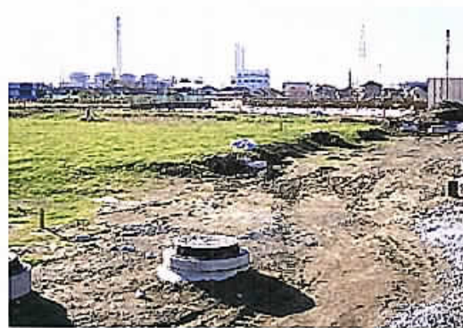
蘇我町線J R内房線・京葉臨海鉄道線交差部工事予定地
