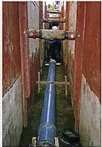
下水道工事現場
