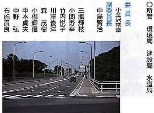
都市計画道路新町若松町線 (若葉区高島町付近)
