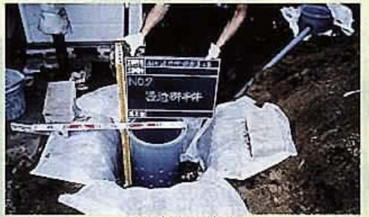
雨水貯留浸透施設
