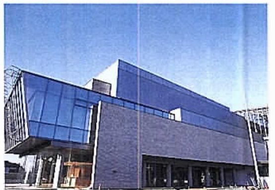
工事が進む生涯学習センター(中央区弁天3丁目)
