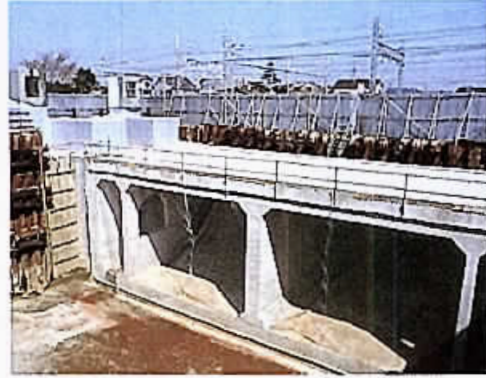
整備が進む美浜長作町線
