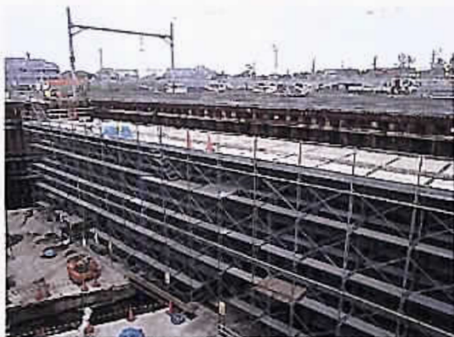
蘇我町線鉄道交差部工事(中央区蘇我町)
