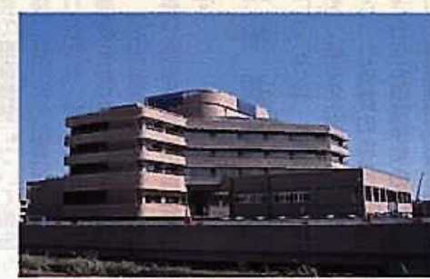
建設が進む青葉病院(中央区青葉町)
