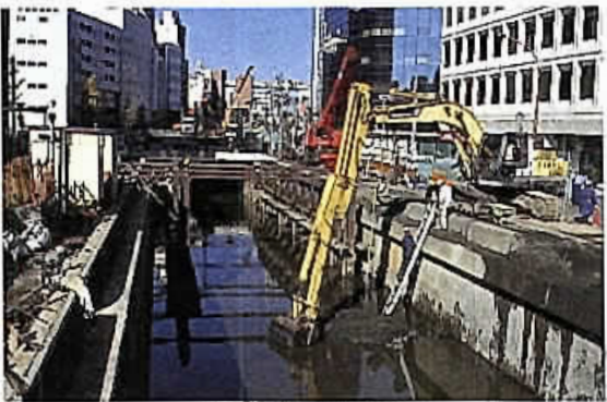
葭川都市小河川改修工事
