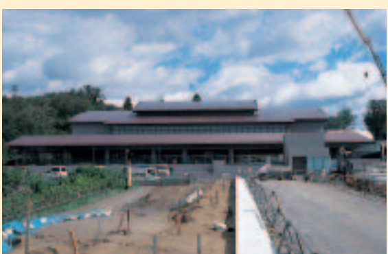
建築中の千葉市斎場(緑区平山町)
