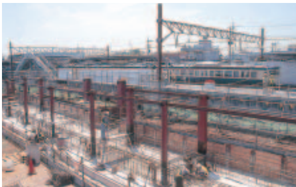
建設工事の始まったJR誉田駅
