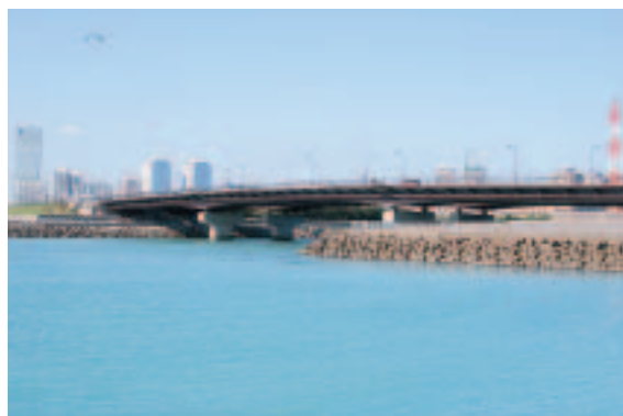
耐震補強が予定されている美浜大橋
