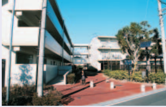
高齢化に対応した星久喜町第二市営住宅
