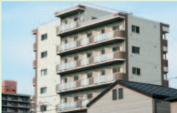
耐震強度が偽造された船橋市内のマンション
