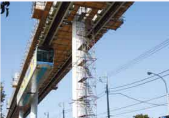
モノレールの軌道桁の塗り替え工事
