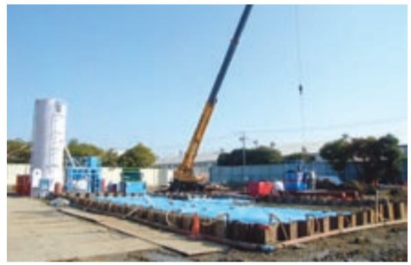
旧新港清掃工場の土壌撤去工事
