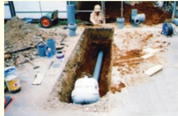
下水道接続工事
