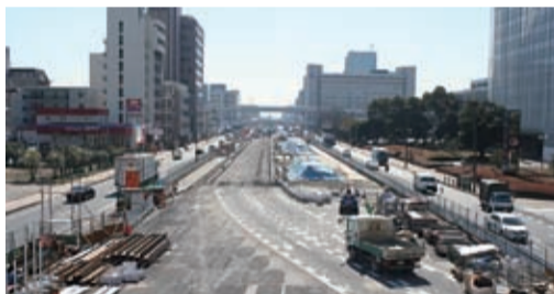
工事が進められる国道357号
