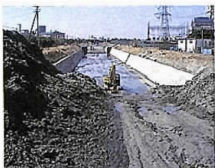
改修が進む生実川(蘇我町2丁目地先)
