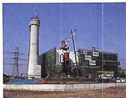
8年度完成予定の仮称三角町清掃工場
