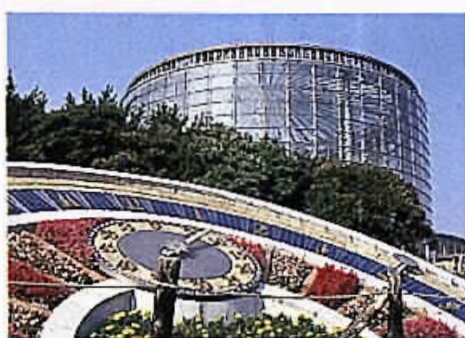
建設が進む全国都市緑化ちばフェア会場
