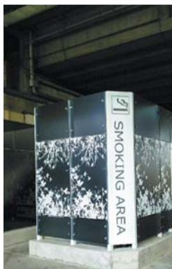
設置した喫煙所
