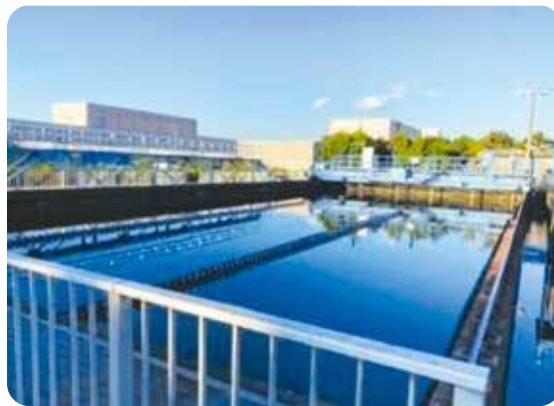
浄化センター整備事業に活用
