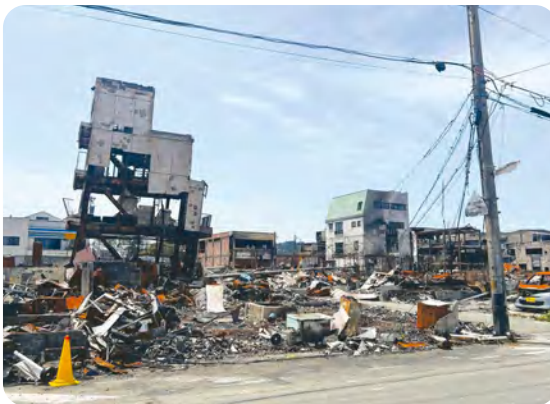
令和6年能登半島地震に伴う大規模火災によるまちの被害
