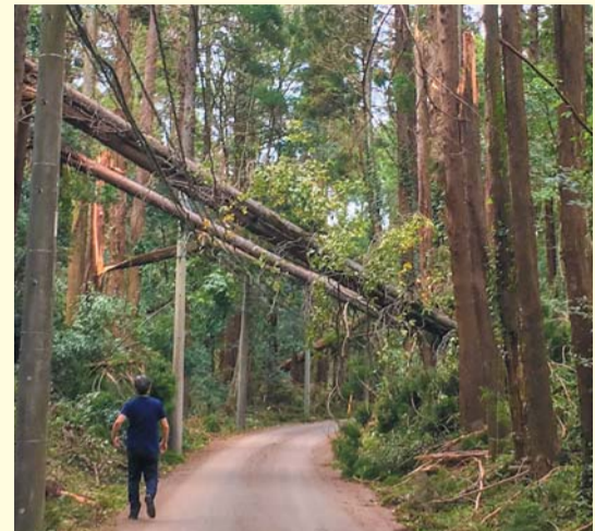
台風15号による緑区の倒木被害
