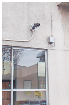
防犯カメラ設置の様子
