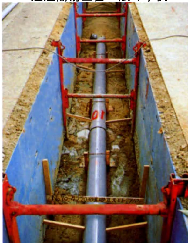
建込簡易土留工法の事例
