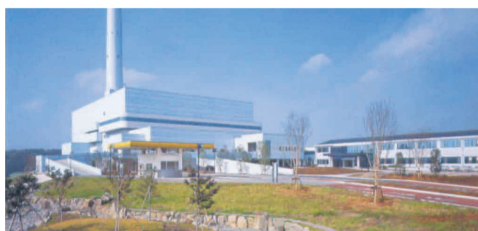
竣工から16年が経過した北清掃工場
