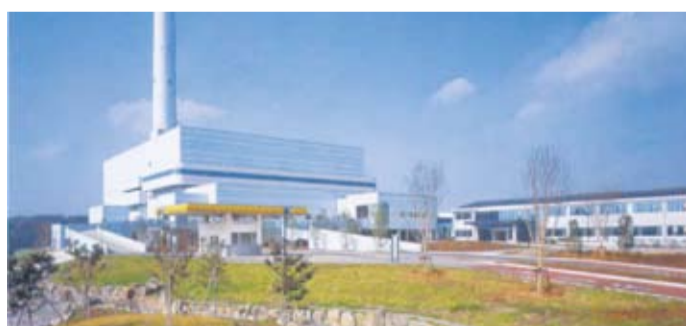
竣工から16年が経過した北清掃工場
