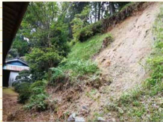
市内の急傾斜地
