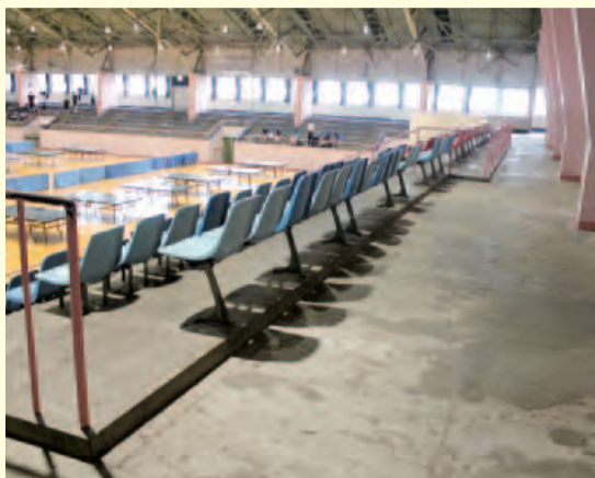
老朽化した千葉公園体育館
