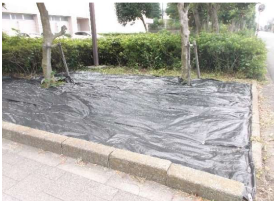
(防草シート敷設後)
