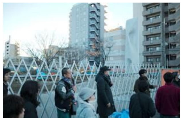
仮社務所工事中の千葉神社
