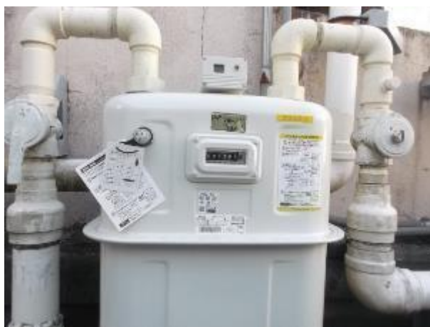
交換したガスメーター機
