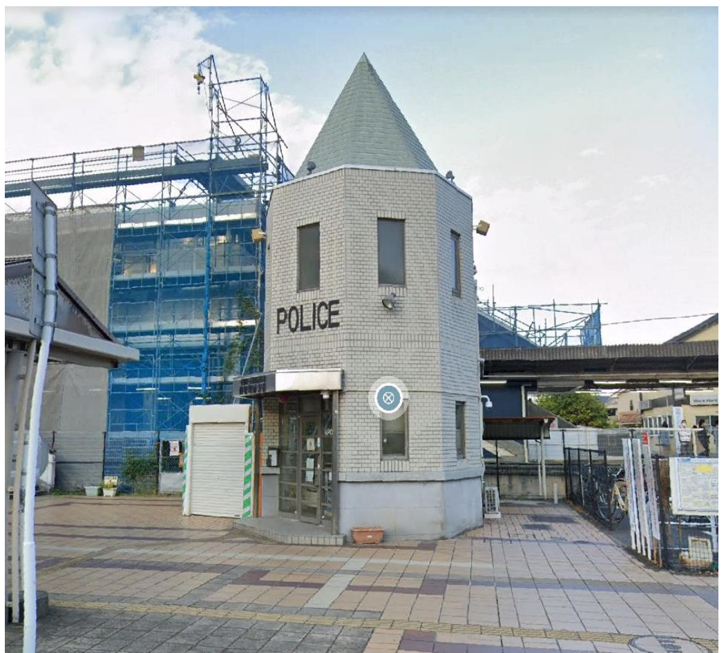
カメラ No. 42 鎌取駅前交番（壁 面設置）
