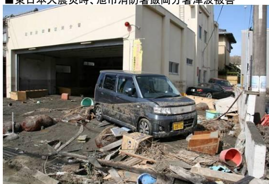
■東日本大震災時、旭市消防署飯岡分署津波被害
