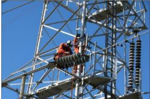
【鉄塔を使用した高所救助訓練】
