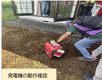
発電機の動作確認
