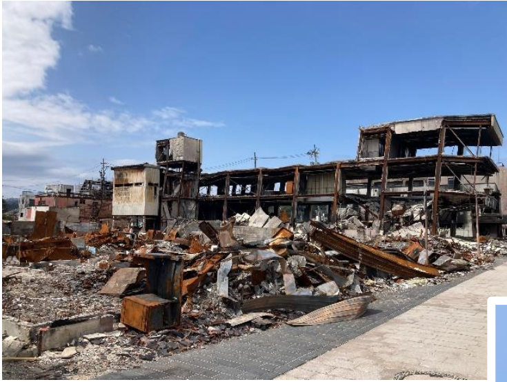
燃烧した朝市通り(輪島市)
