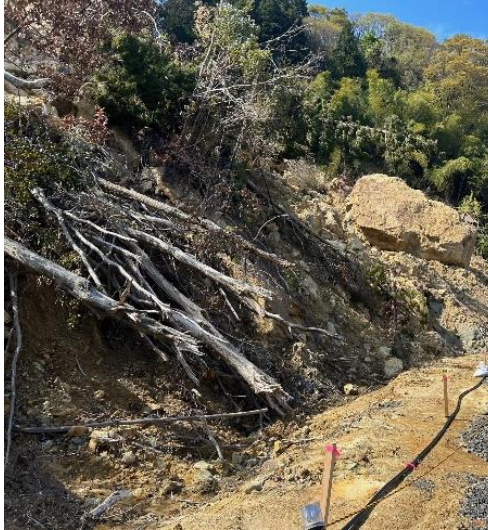
がけ崩れ(珠洲市)
