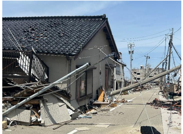
電柱などが地震により転倒(珠洲市)
