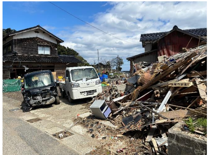
津波の被害を受けた住宅(珠洲市)
