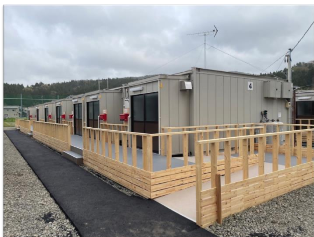
応急仮設住宅の完了検査
