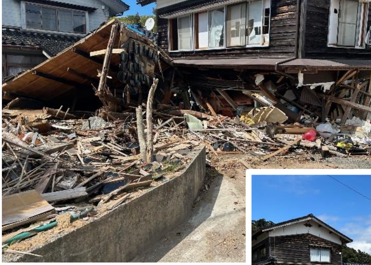
津波の被害を受けた住宅(珠洲市)
