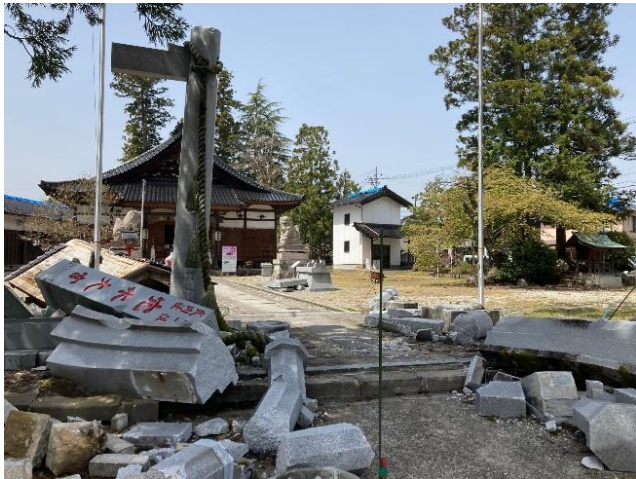
神社の鳥居などが崩壊(穴水町)
