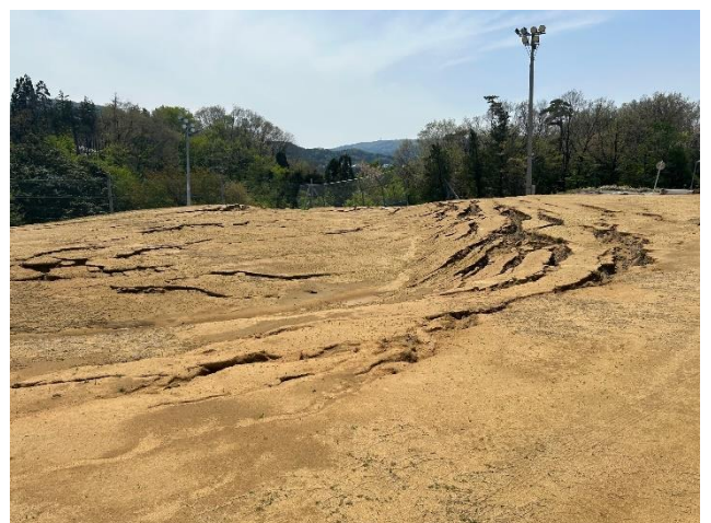
液状化した小学校の校庭(輪島市)
