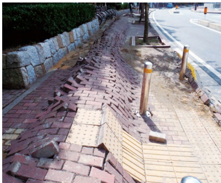
歩道の隆起<美浜区ひび野1丁目>
