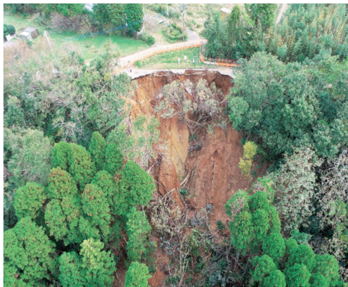
崖崩れ<緑区越智町>
