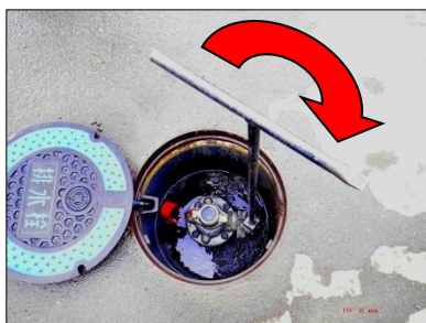
【スピンドルドライバー取付け】
