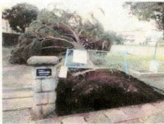
千草台東小 (倒木によるフェンス破損)
