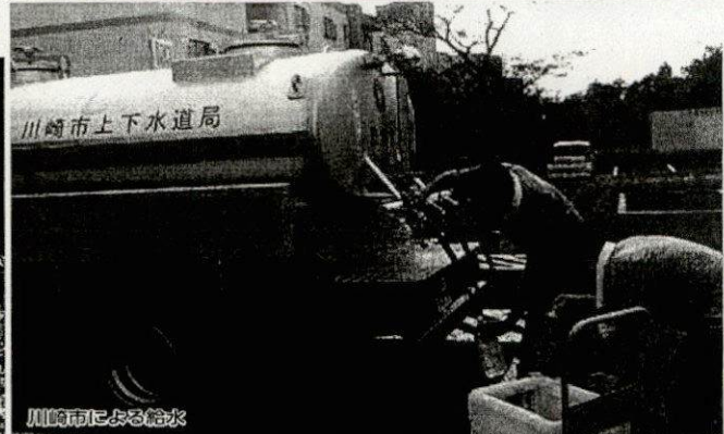
川崎市による給水
