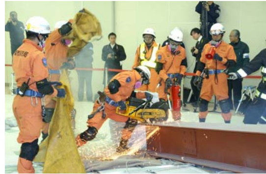
・カッターによる瓦礫の撤去
