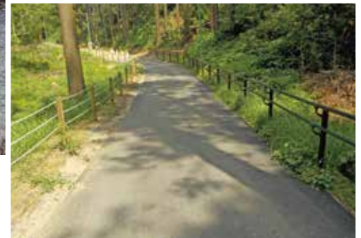
流出した土砂撤去後の園路(泉自然公園)
