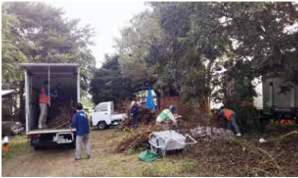
倒木や瓦礫の片付け (花見川区犢橋町)
