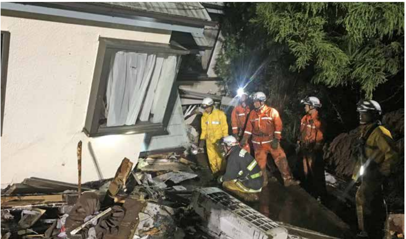
土砂崩れ現場における消防、警察、自衛隊等の救出活動(緑区誉田町3丁目)
