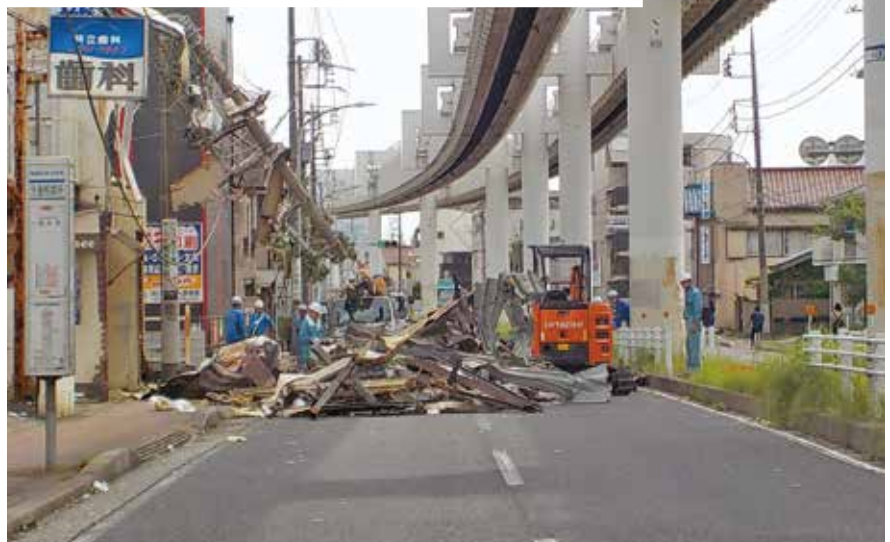
倒壊したプレハブの撤去作業(稲毛区作草部1丁目)
