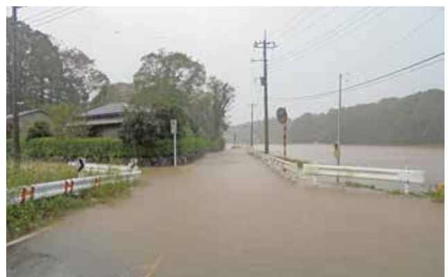
用水路が氾濫し、冠水した道路(緑区平川町)
