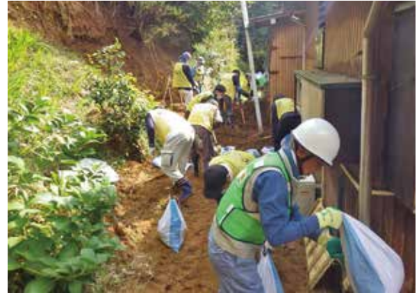
土砂崩れにより流出した土砂の土のう詰め及び撤去 (若葉区野呂町)
