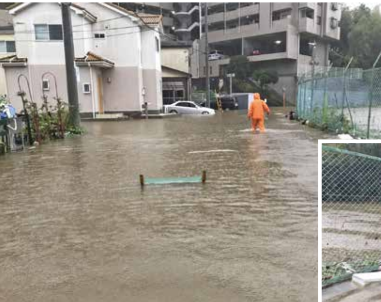
坂月第2調整池の越水により、冠水した道路 (若葉区千城台南4丁目)
