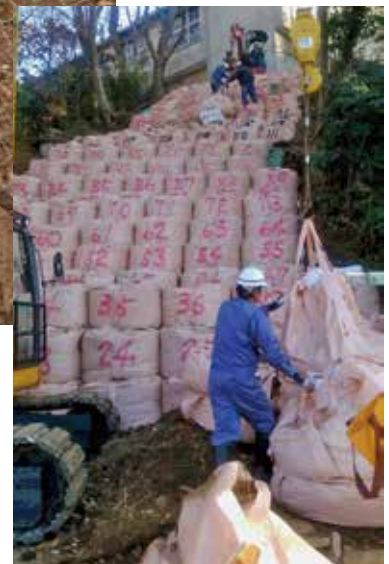
土砂崩れ箇所への応急復旧 【大型土のう設置】 (千城台西中学校)
