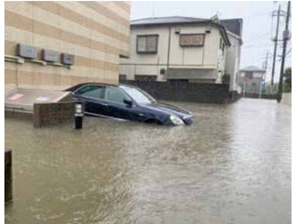
道路冠水(中央区都町)
