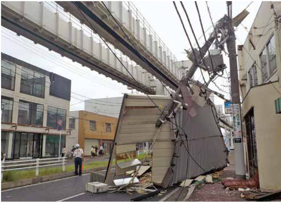
国道126号上に倒壊した プレハブ (稲毛区作草部1丁目)
