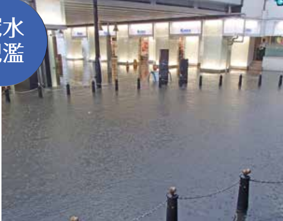
道路冠水(京成千葉駅前)
