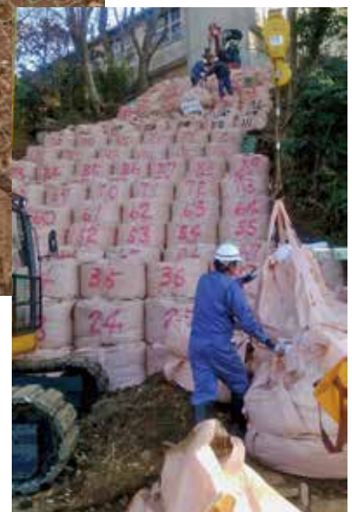
土砂崩れ箇所への応急復旧 【大型土のう設置】 (千城台西中学校)
