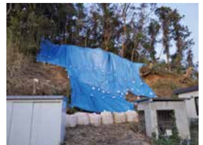
土砂崩れ箇所の応急復旧 【ブルーシート養生、大型土のう設置】 (椎名公民館裏山)
