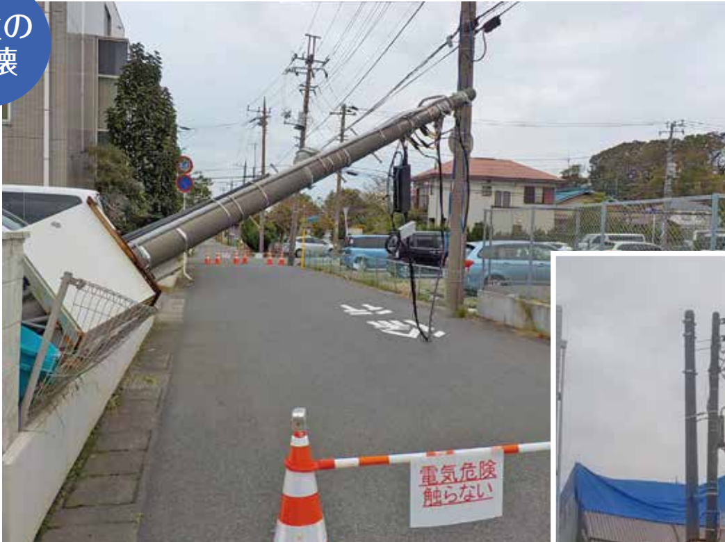
倒壊した民有地内の電柱(中央区都町1丁目)
