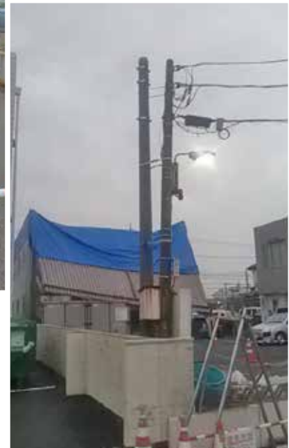
倒壊した民有地内の電柱が復旧 (中央区都町1丁目)
