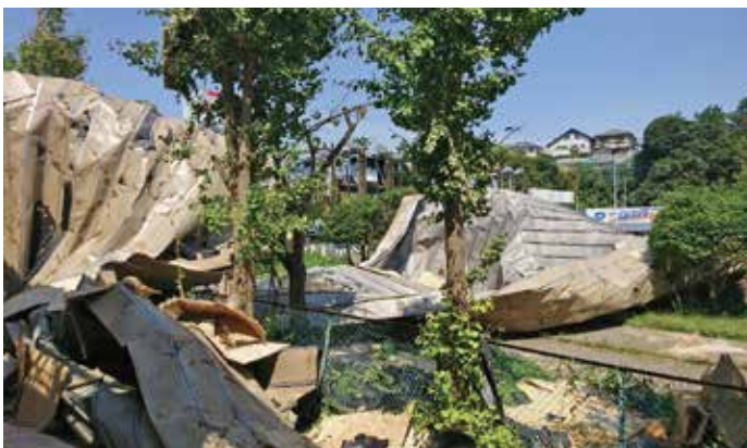
屋内運動場の屋根から落下した金属製の屋根材(稲浜小学校)
