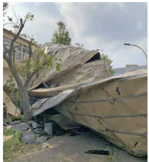
屋内運動場の屋根から落下した金属製の屋根材(稲浜小学校)
