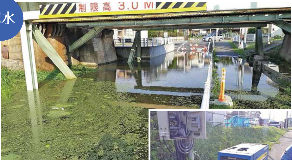
停電のために道路排水ポンプによる排水ができず、冠水した道路(村田町JR内房線地下道)
