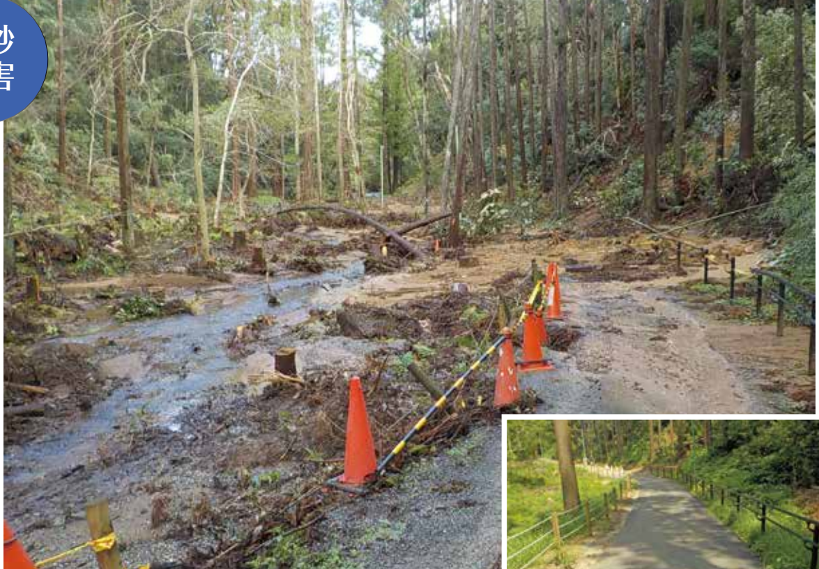
斜面が崩れ、土砂が園路に流出 (泉自然公園)
