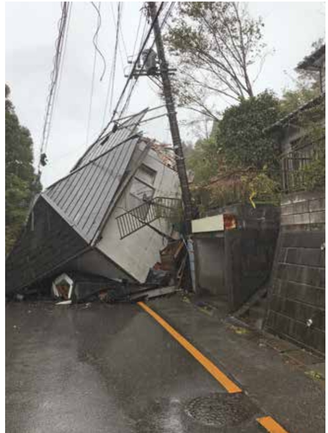
土砂崩れにより倒壊した家屋 (緑区誉田町3丁目)
