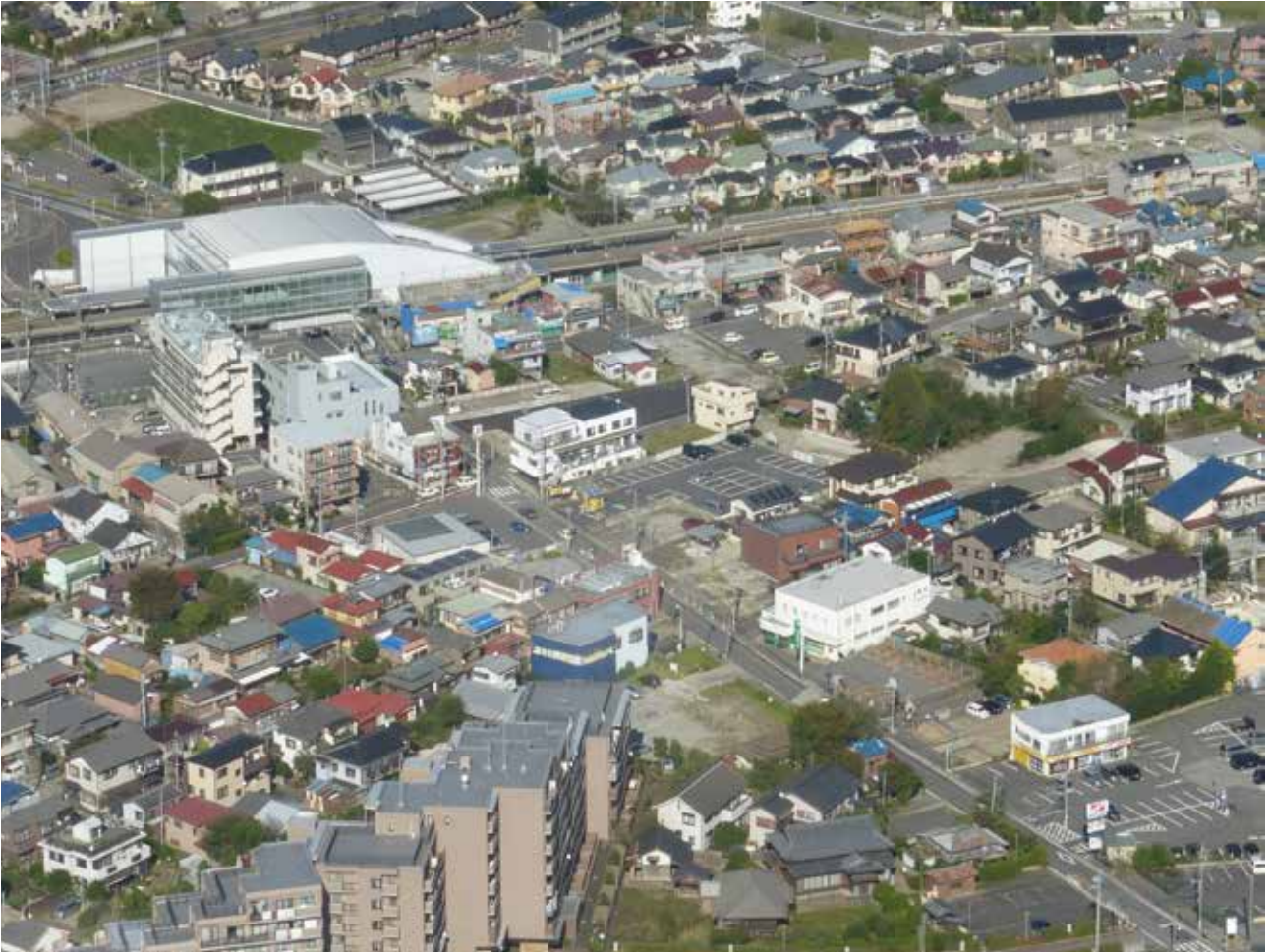
ブルーシートで養生した家屋(誉田駅周辺)
