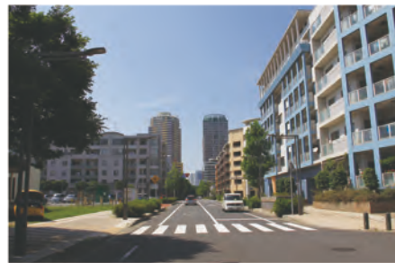
無電柱化されたベイタウンの街並み Makuhari Bay Town townscape with the utility poles removed
